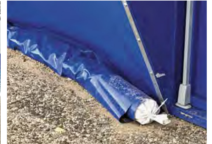
Fußpunktdetail der Traglufthalle neben einer Notausgangstür
