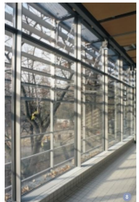
8: Stahl-Glas-Fassade, 1. Obergeschoss, Lüftungsrinne entlang der Fassade
